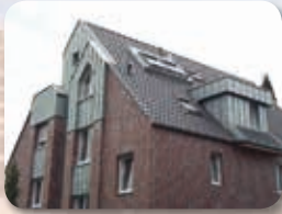
Klempner- und Fassadenarbeiten
